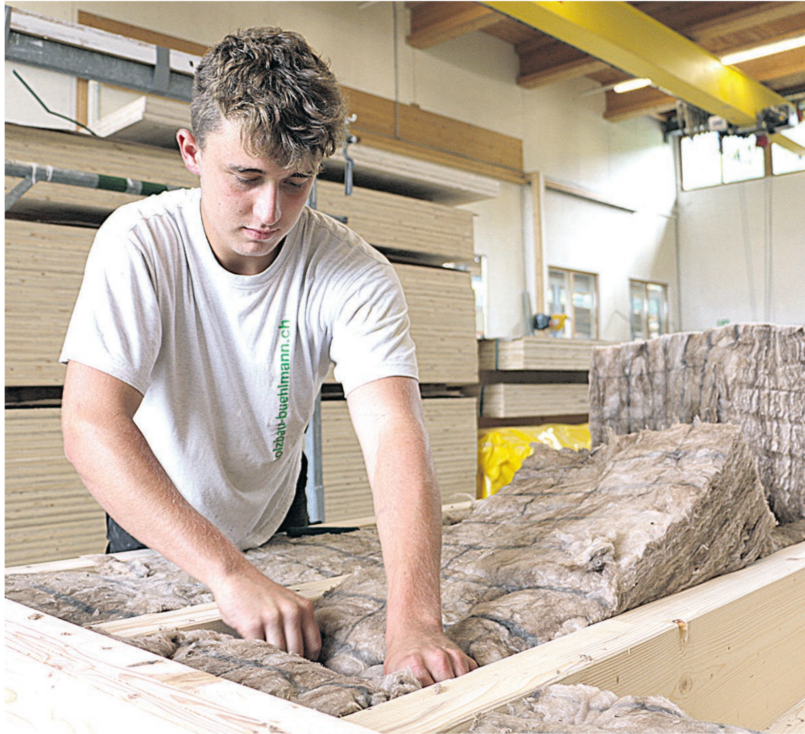
Zimmermann Tobias Hüsler legt Glaswolle zur Isolation eines Dachelements ein.
